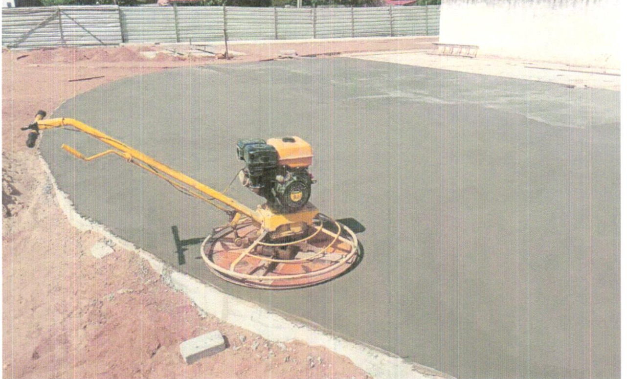
FOTO 18 - CONCRETO SIMPLES FABRICADO NA OBRA, LANÇADO E ADENSADO
