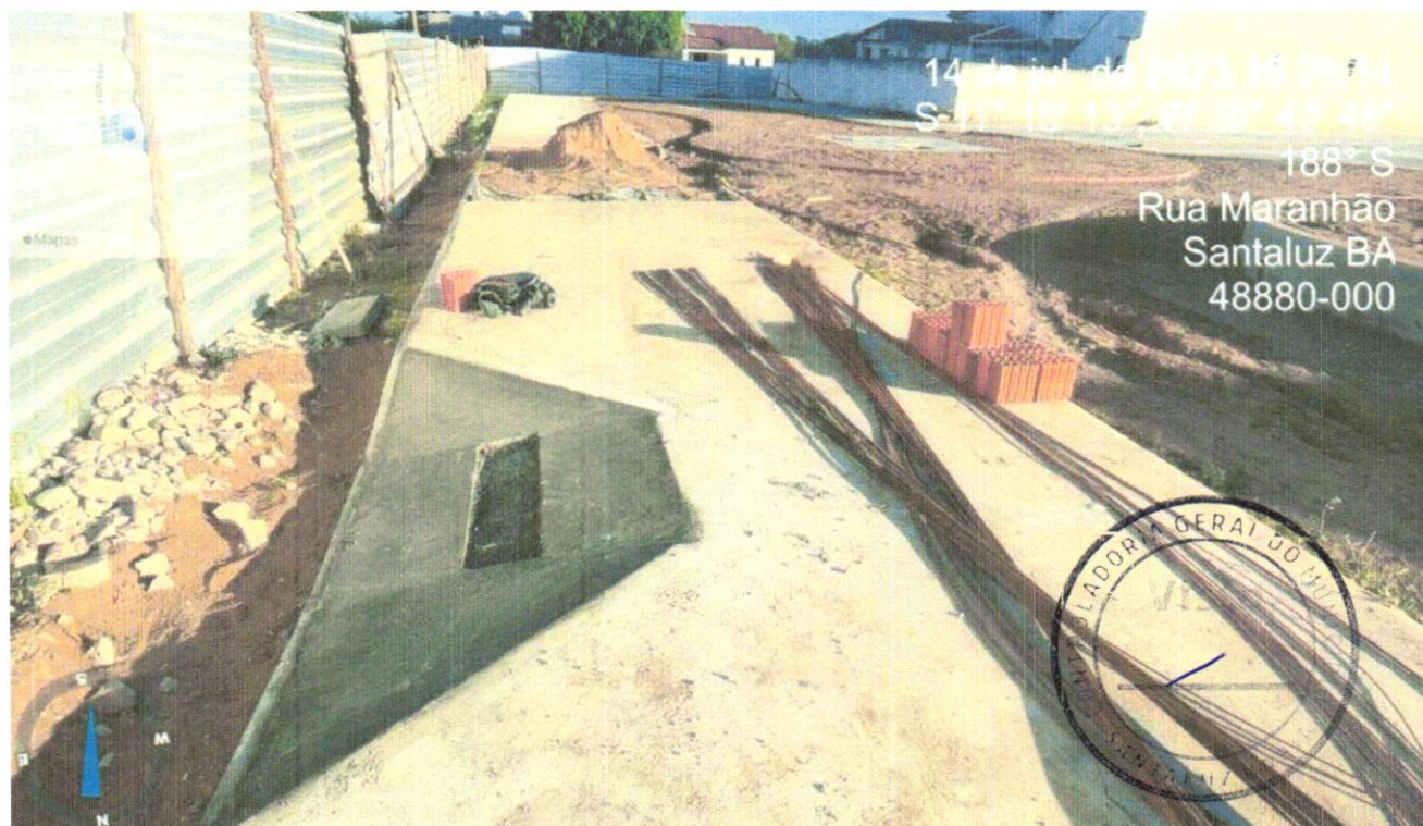
FOTO 12 - Rampa padrão para acesso de deficientes a passeio público, em concreto simples Fck=25MPa
