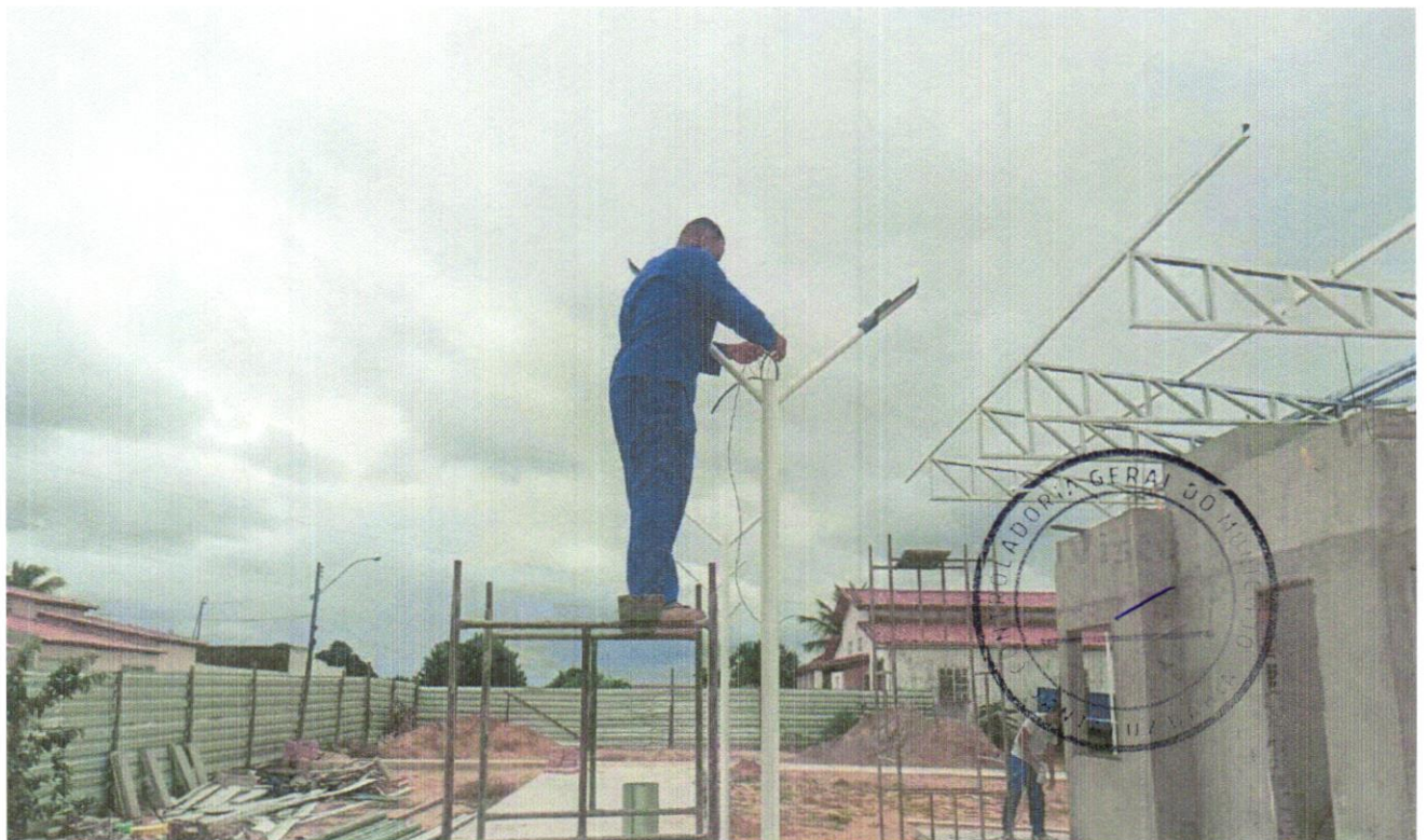
FOTO 10 - POSTE DE AÇO CONICO CONTÍNUO , ENGASTADO, COM QUATRO PÉTULAS
