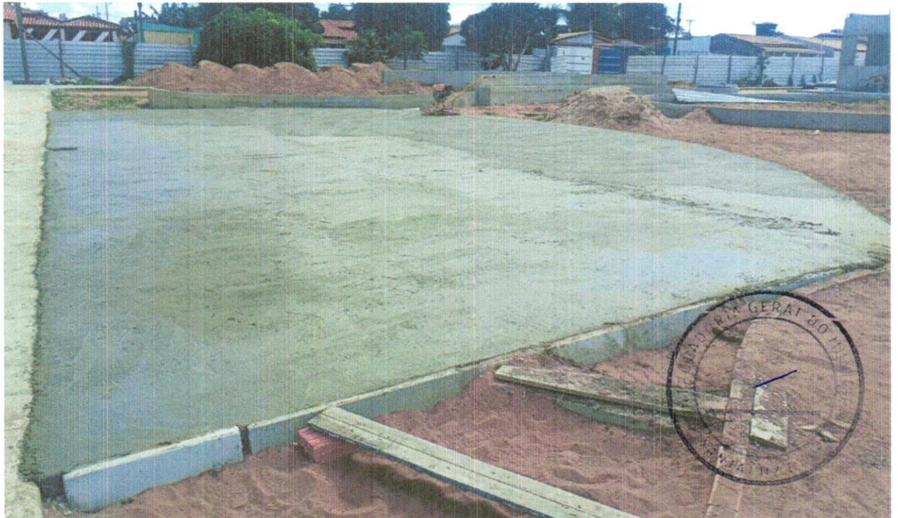
FOTO 18 - CONCRETO SIMPLES FABRICADO NA OBRA, LANÇADO E ADENSADO
